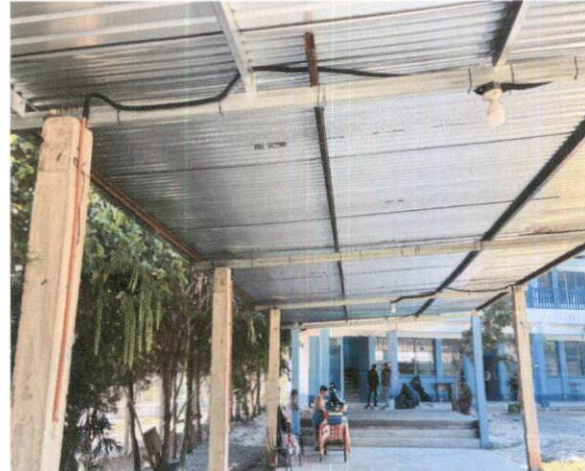
Foto 10: Ampliación de galera de usos múltiples e instalación de energía eléctrica.
