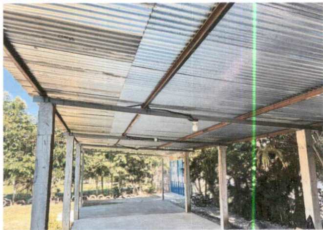
Foto 9: Instalación de energía eléctrica en la galera de usos múltiples ya finalizado
