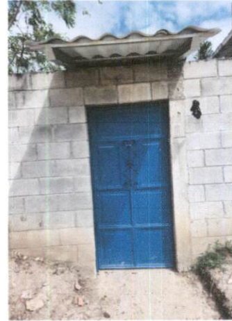
Foto 6: Mejoramiento de puerta de salida de emergencia, con techo protector y torta de cemento ya finalizada
