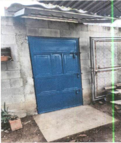
Foto 5: Mejoramiento de puerta de salida de emergencia, con techo protector y torta de cemento ya finalizada
